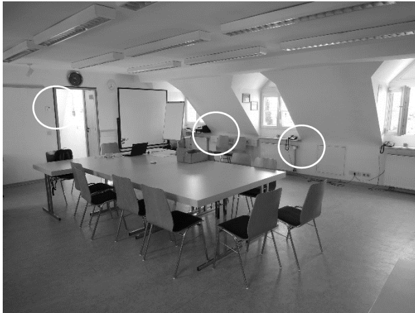
Besprechungsraum: 6 Stellantriebe, 1 Raumsensor
